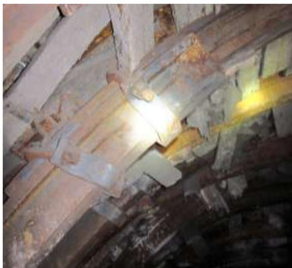
Рисунок 2 – Перекос скоб и планок замковых соединений ЗПКМ
