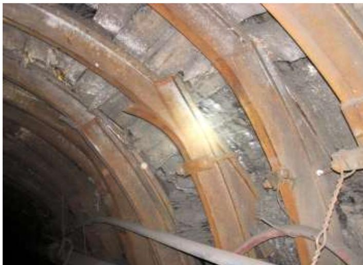
Рисунок 1 – Деформация и отрыв планок замковых соединений АПЗ-030
